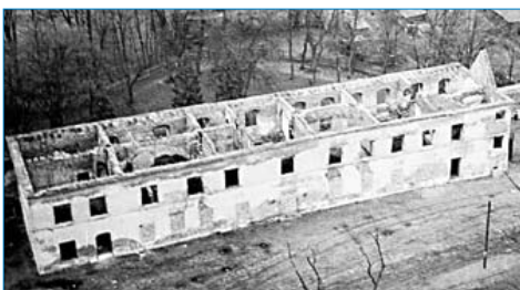
Zdjęcie powojenne. Widoczne zamurowane otwory okienne i drzwi wejściowe. Fot. Archiwum (prawdopodobnie Jan Małnicki)
