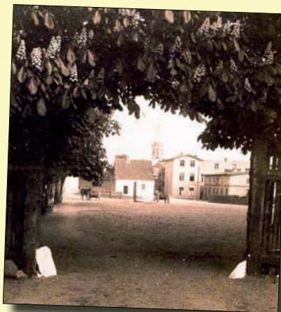
Interesujące ujęcie terenu dawnego przedzamcza zamku brodnickiego. Patrząc dziś z miejsca, w którym wykonano zdjęcie, widzielibyśmy zapelniony samochodami parking przy Pałacu Anny Wazówny. Tam, gdzie stoi wóz po prawej znajduje się obecnie toaleta
