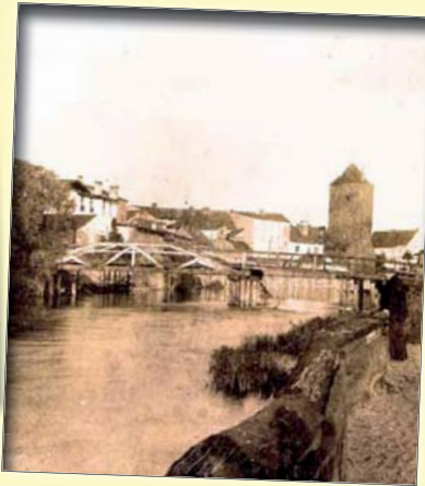
Widok na most przy dzisiejszej ulicy Kościelnej. Konstrukcja mostu najwyraźniej drewniana. Dziś mamy most żelazny. Niedawno poddany remontowi
